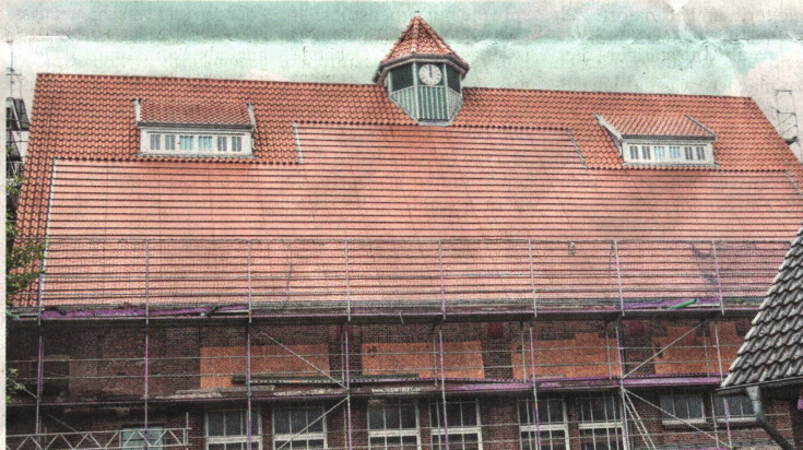
Auf der Rückseite wurden rote Solarpanels installiert.
