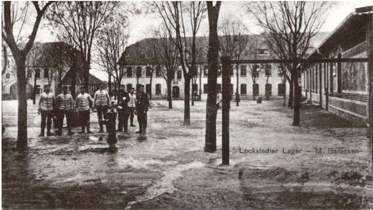
Der Hof zwischen den Massivbaracken
